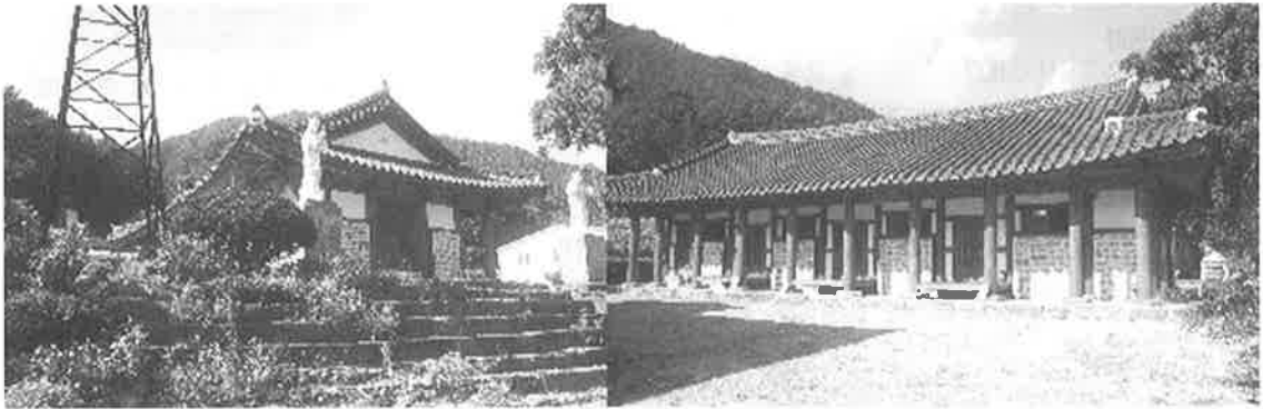
복원된 되재 한옥성당의 정면(오른쪽)과 측면
