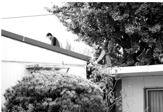
복지시설 하늘향 지붕엇기 작업
